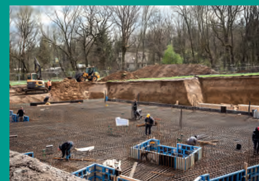
Alles im Zeitplan: Der Baufortschritt im April 2023.
