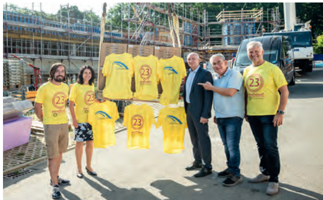
Hoch hinaus mit dem Kran auf der Klinik-Baustelle: Klinik-Geschäftsführer Tomas Kallenbach (3. von rechts) begrüßte zur Übergabe der Laufshirts Stefan Engelhardt vom Sportsportbund, Rotary-Präsidentin Dr. Cornelia Haase-Lerch, Klinik-„Laufdirektor“ Dieter Erler und Ralf Ludwig vom Rotary Club (von links).
